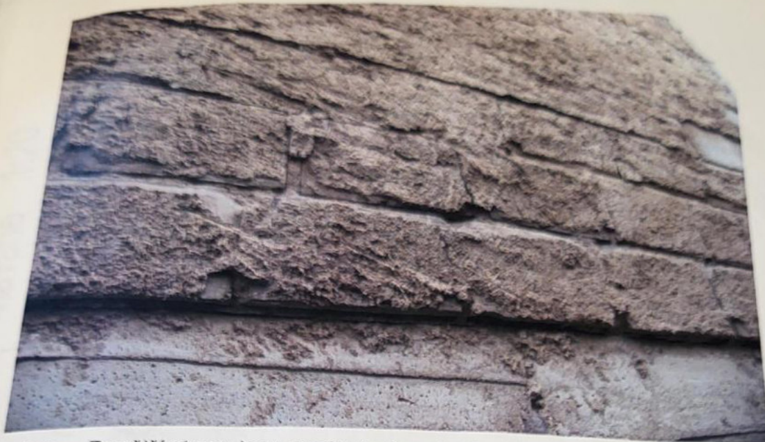
Foto č. 4 Z vnější strany jsou mezi tvárniciemi stěny č.p.12 nad základem patrné trhliny (zejména v ložných spárách). Protože je základ neporušen a ani na vnitřním líci stěny nejsou dosud žádné trhliny, musely tyto trhliny ve stěně být již před havárií.
